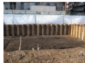
汚染土除去状況
