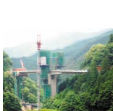
奈良国道168号1-1号橋工事
