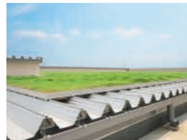
折板ダブルバック屋根と屋上緑化
