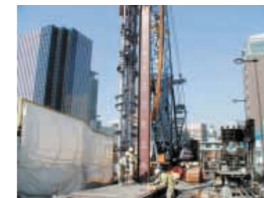
開削部土留め施工
