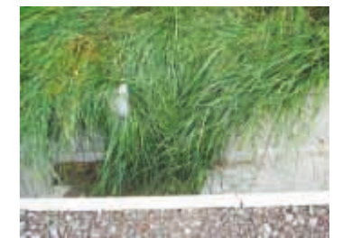
植生土嚢から植物が茂った脱出口
