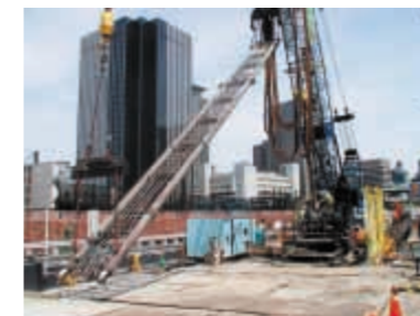
開削部SMW芯材建込み
