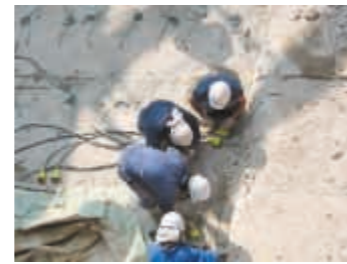
放電破碎工法
