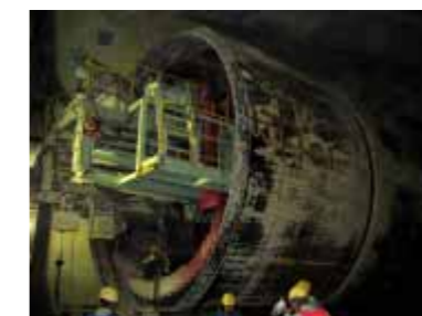
立坑内でのシールド機Uターン
