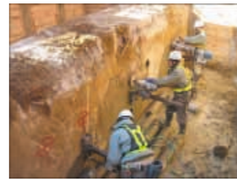
油圧式静的破碎工法
