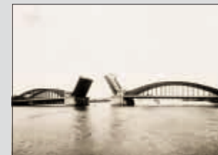
勝鬨橋 東京 1937 (昭和12) 年
