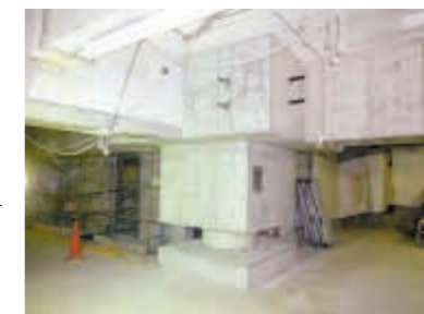
免震装置設置
