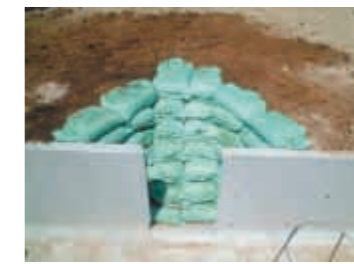
小動物脱出口（土嚢は植生土嚢）
