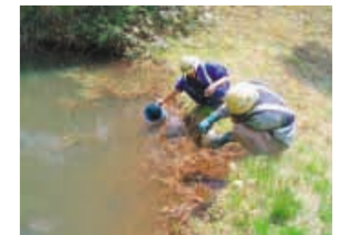
工事範囲外へ放流
