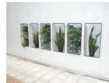
施工中の仮囲いも緑化
