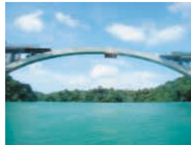
ワルミ大橋全景
