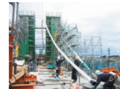
斜材保護管架設
