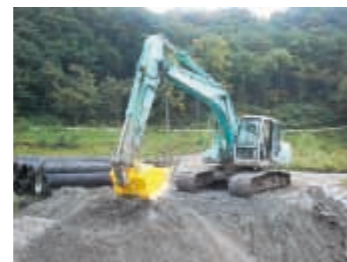
コンクリートガラの活用
